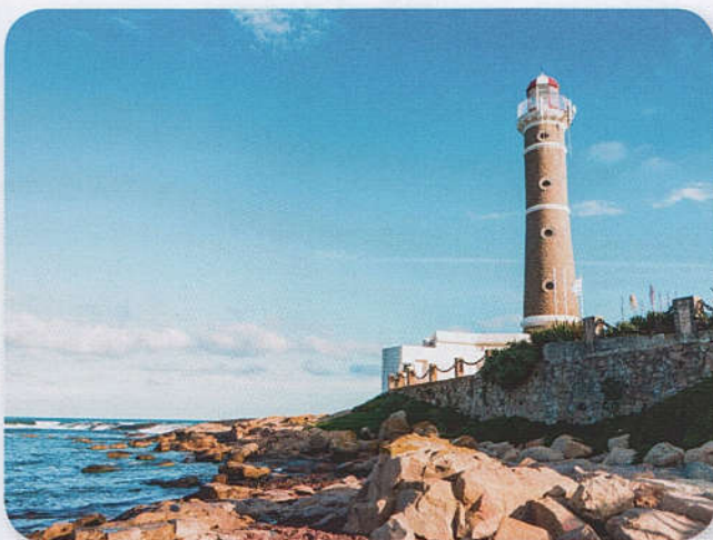
L'érosion d'une falaise exposée aux mouvements des vagues de la mer.
